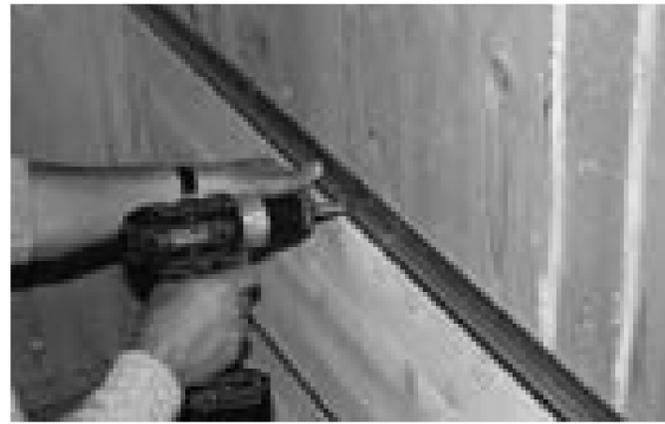
Die Multifunktionsleiste in die Nut der Decker Massivholz-Paneele einlegen und mit der Wand verschrauben.
